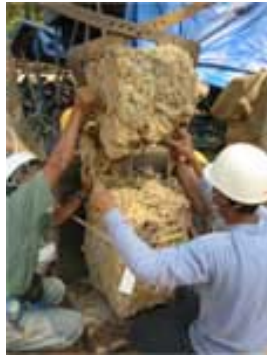
大型ラテライト材をステンレスバーで補強した接合修復 Bonding Restoration of big Laterite blocks using stainless steel bar for reinforcement
