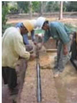
ステンレスプレートの補強によるラテライト材の修復 Restoration of Laterite blocks using stainless steel plate for reinforcement
