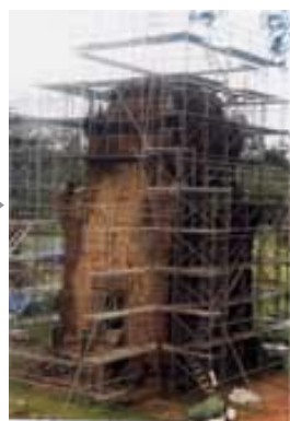
プラサート・スーブラ N1 塔の解体の様子
