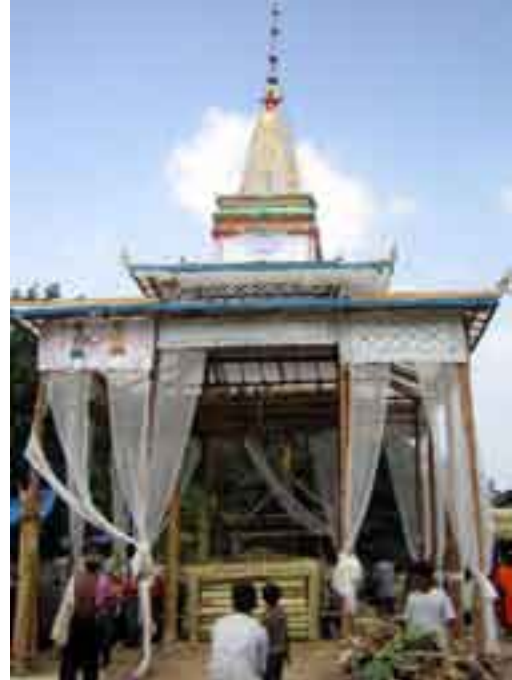
Pl. 2.9-3 Mén for cremation of a monk ( Vat Run , Angkor region): the roof is supported by each four pillars in four lines. It is consisting of a nef where the coffin is laid in state (in the box made of banana timber) and two bas-côtés . A Rahu is also seen on the pediment. ある僧侶の火葬用 Mén (アンコール地域, Vat Run ): 屋根は四列に配された四本の柱で支えられており、棺(ここではバナナの木で外装された箱内に収められている)を収容する身舎と両側室とが形成されている。ペディメントにはやはり Rahu が見受けられる。
